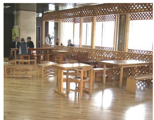
北海道庁1階ロビーのトドマツ圧縮材フローリング
